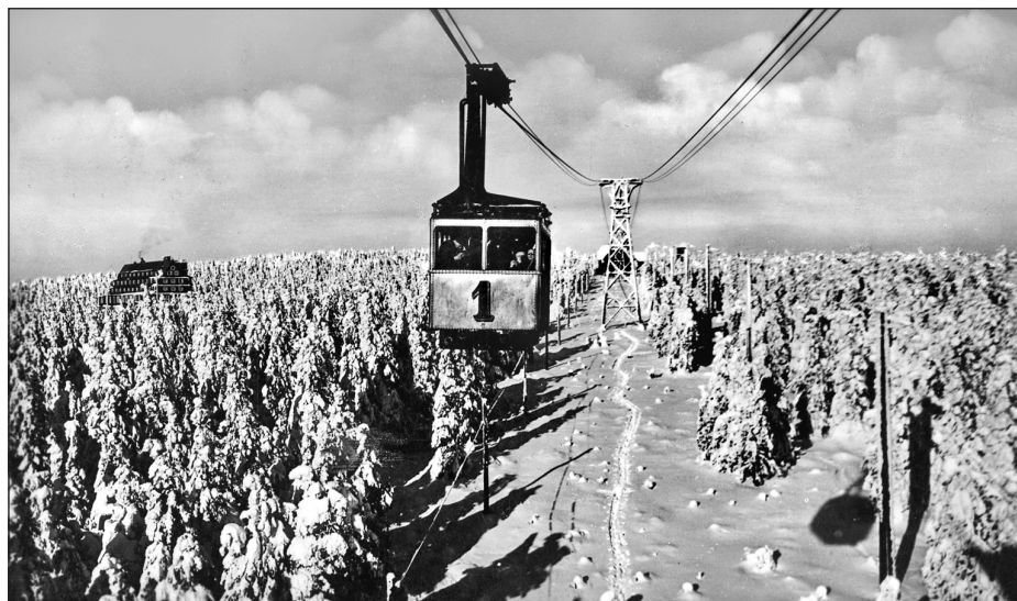
Obr. 17. Původní kabina lanovky č. 1 vyrobená českolipskou vagónkou v roce 1928 pro Janské Lázně na Černou horu (fotoarchiv Krkonošské muzeum ve Vrchlabí).
